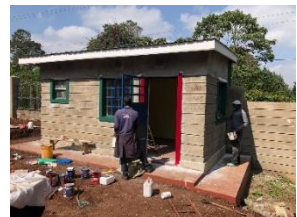
Diese Quarantäne – Unterkunft musste heuer für Mitarbeiter gebaut werden
